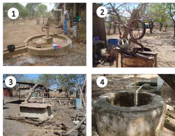
Figura 3. Pozos excavados a mano (pozos domiciliars). (1) Pozos con bomba de palanca (2) Pozos con bomba de mecate (3) Pozos con bomba eléctrica y parcialmente cubierto (4) Pozos con bomba eléctrica y descuberto.
