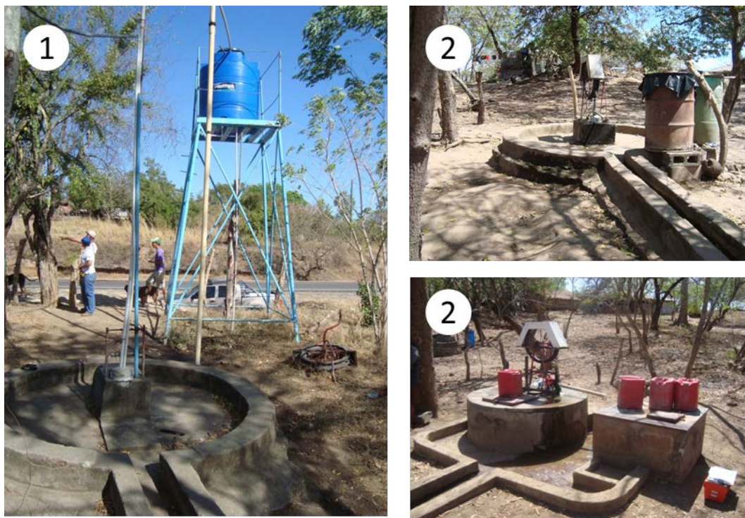
Figura 5. Pozos perforados atendidos por la comunidad para el suministro de agua de consumo humano (1) Pozo perforado provisto de una bomba eléctrica y un tanque de almacenamiento que distribuye el agua por tubería a un caserío. (2) Pozos perforados provistos de una bomba de mecate atendido por la población para el suministro de agua en un caserío poco disperso, la población retira el agua en la fuente.
