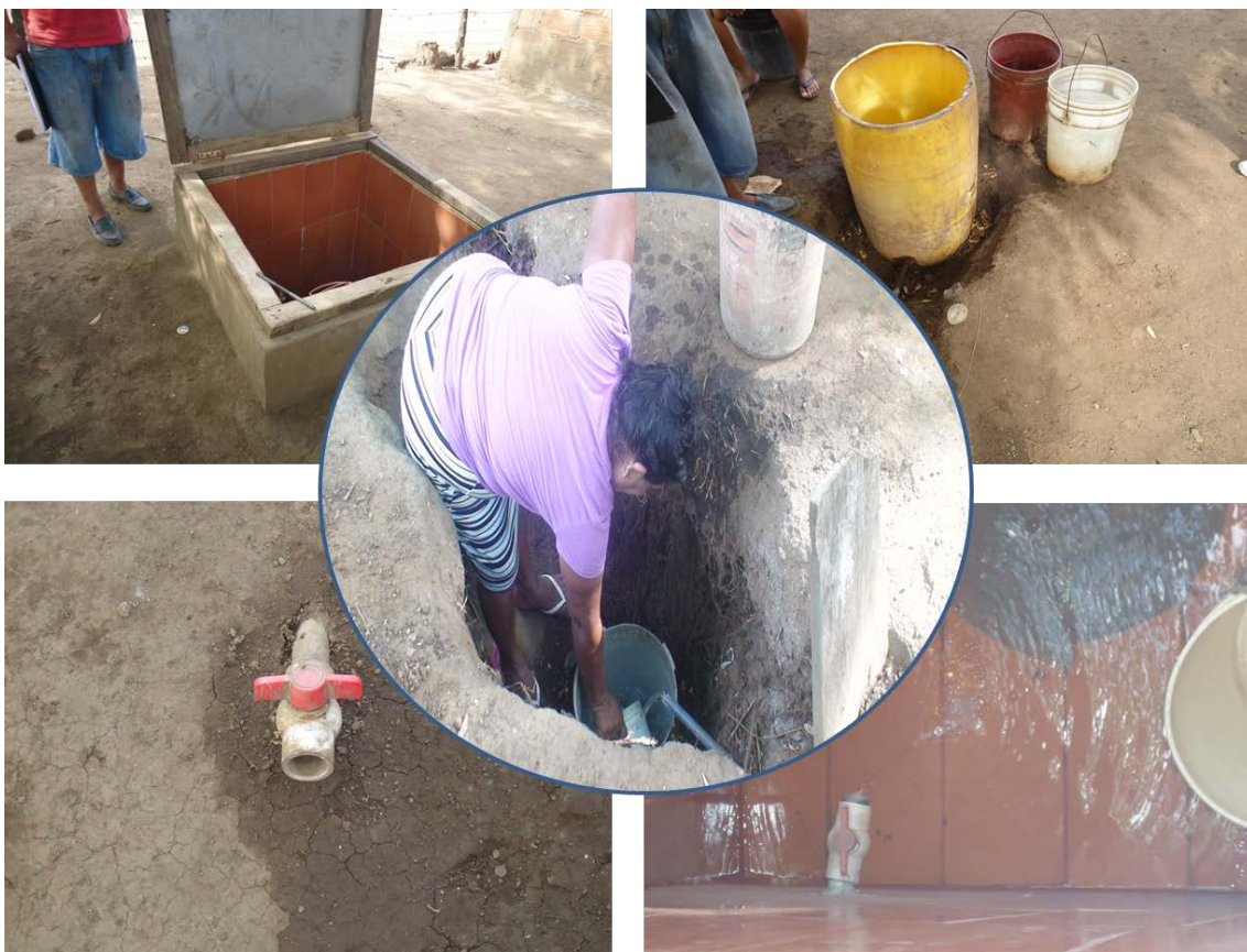
Figura 8. Agujeros a nivel del suelo en la red de distribución para acceder al agua de consumo debido a la baja presión del sistema. Comunidad Jorge Barreto, Malpaisillo-Larreynaga.
