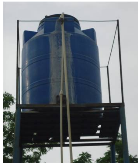
Figura 11. Depósitos de sales de calcio y magnesio (agua dura) en las superficies de un tanque de agua. Comunidad Jorge Barreto, Malpaisillo
